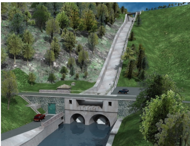
Spodní část skluzu a vývar - srovnání dnešního stavu (vlevo) a stavu po rekonstrukci (vizualizace)
