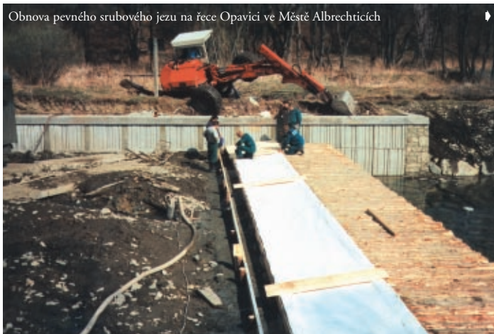
Obnova pevného srubového jezu na řece Opavici ve Městě Albrechticích
