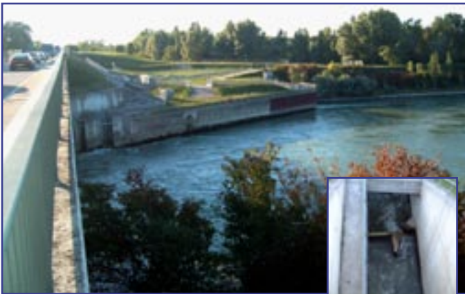
Obr. č. 1 - Přeprava Iffenzheim na řece Rýn, pohled levý břeh s rybochodem, z detailu jsou patrné značné rychlosti proudu.
