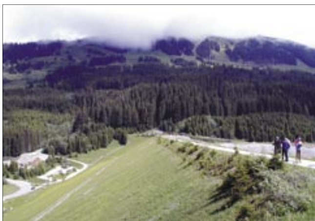
■ Pohled na hráz Durlassboden a starý sesuv v pravém zavázání
