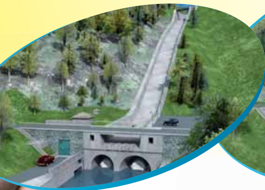
Spodní část skluzu a vývar - srovnání dnešního stavu (vlevo) a připravovaných úprav
