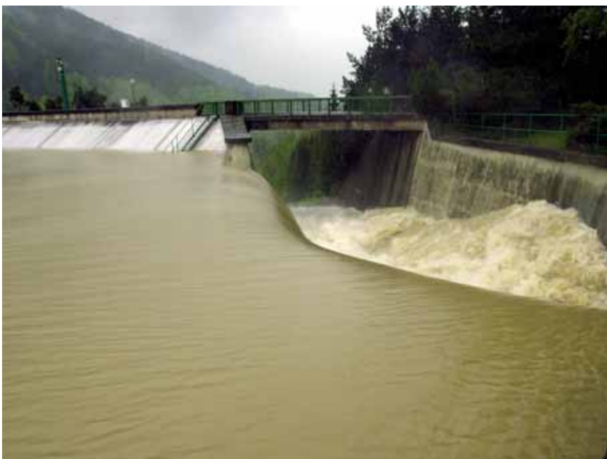
Bezpečnostní přeliv přehrady na Morávce při dosažení maximální hladiny za povodně, 18.5.2010
