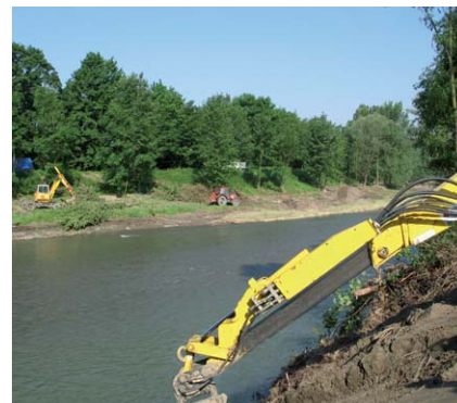
Ostravice, Ostrava - centrum města - odstranění povodňové škody
