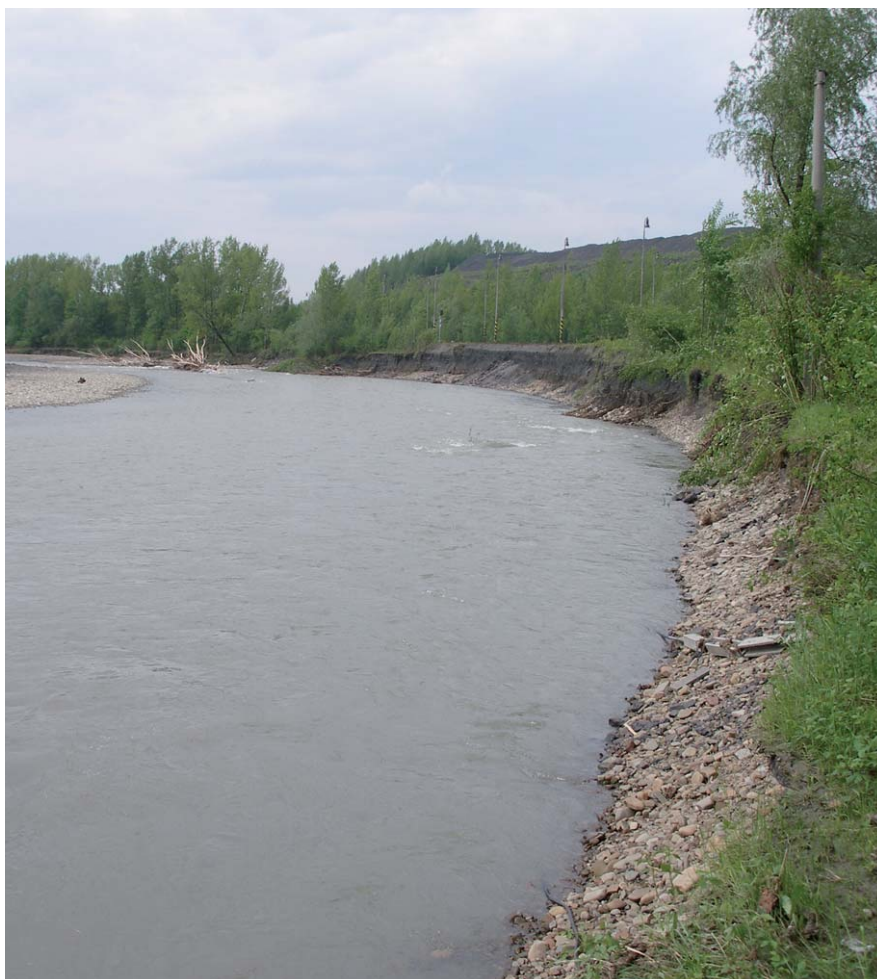
Povodňové škody na Ostravici po květnových a červnových povodních
