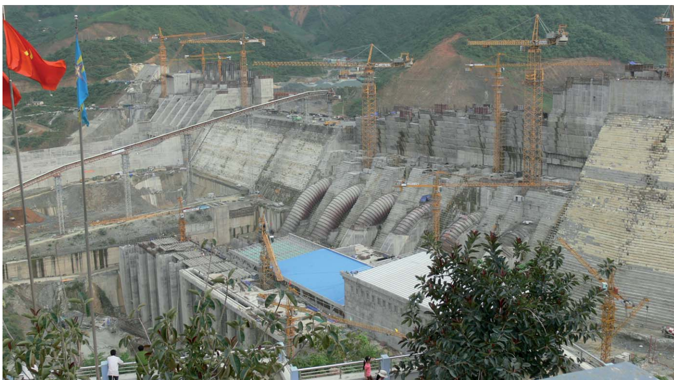
Rozestavěná hydroelektrárna s výkonem 2400 MW.
