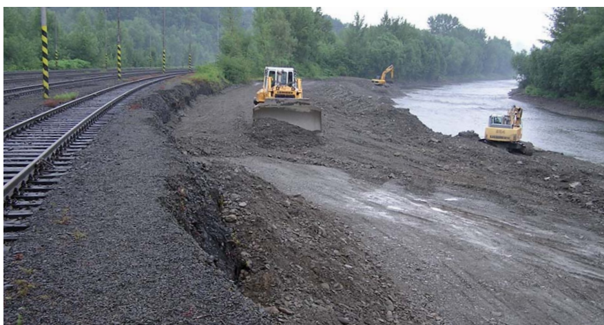
Rozhrnování vrstvy štěrku před hutněním
