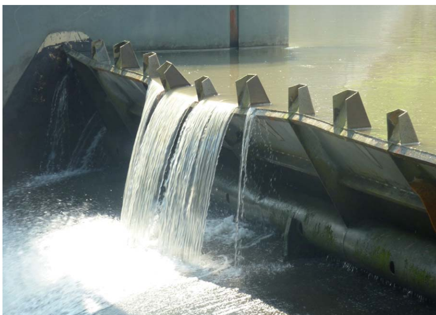
Ostravice - jez ve Vítkovicích
