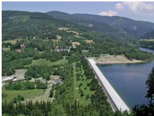
Morávka po rekonstrukci asfaltbetonového pláště
