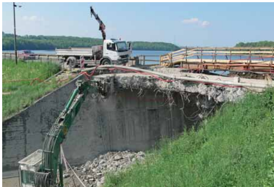
Bourání horního mostu
