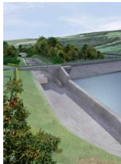
Spadiště a přeliv po opravě
