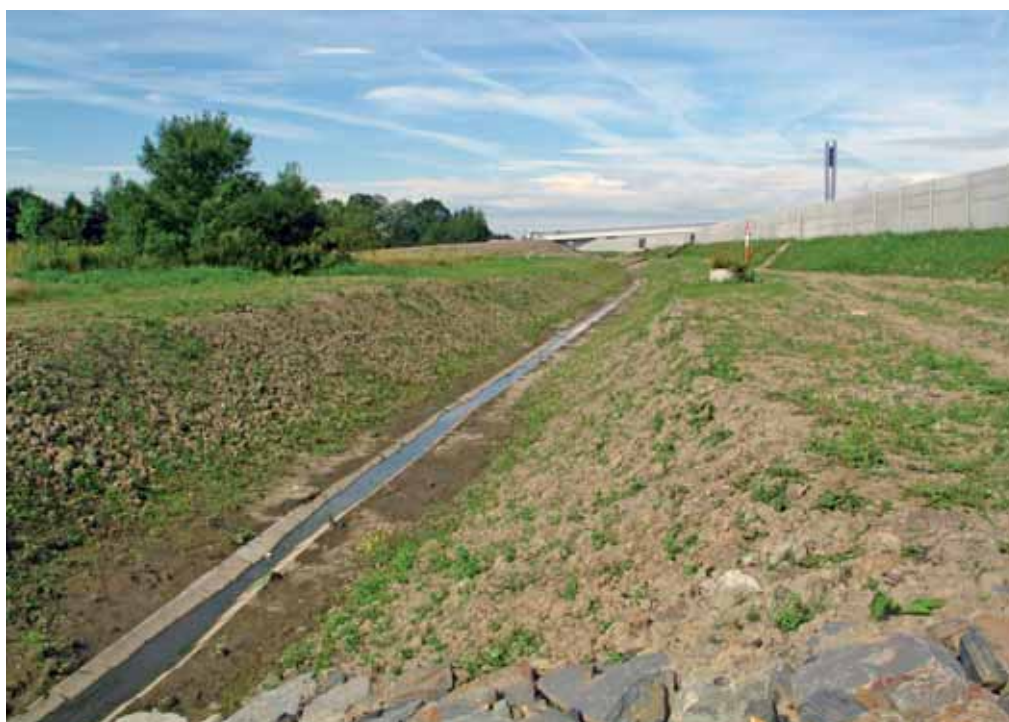
Odvodňovací příkop podél dálnice
