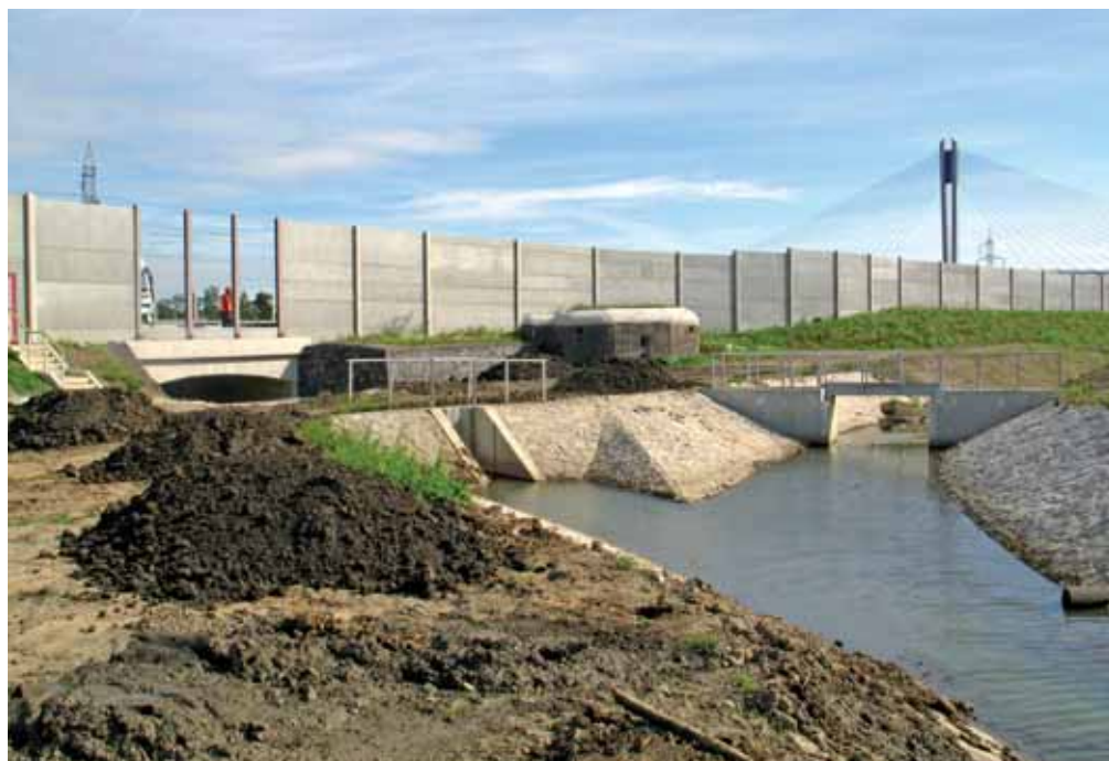
Rozdělovací objekt na Bajcůvce
