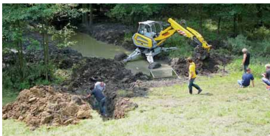
Čištění vtoku do spodní výpusti
