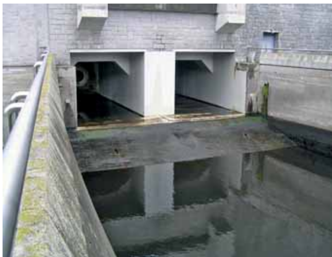
Pokles vody ve vývaru zhruba o 80 cm – komory rozstříkavacích uzávěrů
