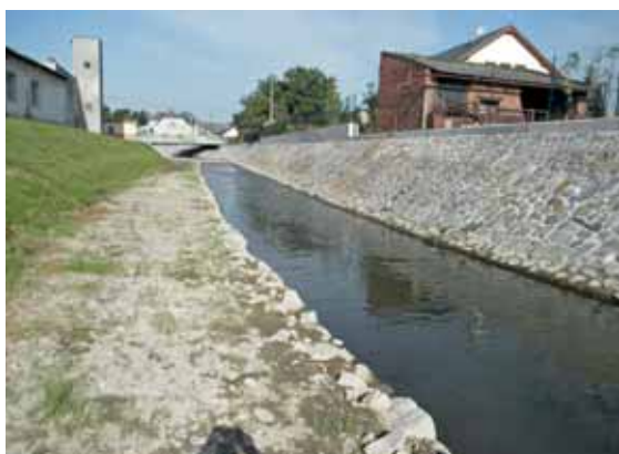
Hotová protipovodňová ochrana Hvozdnice–Otice
