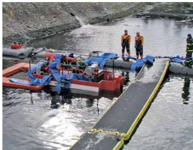
Druhý pokus o vyčerpání vývaru: zahrazení vývaru gumovými vaky naplněnými vodou, obslužný plovoucí chodník a obří plovoucí čerpadlo HZS z Ostravy před započítím čerpání
