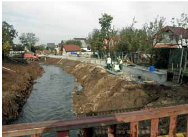
Průběh výstavby na Hvozdnici
