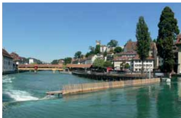
Řeka Reuss a nátok na elektrárnu v Luzern
