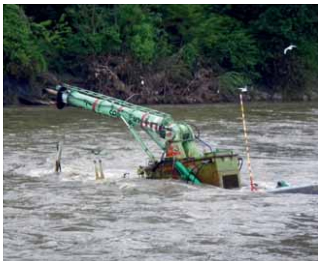
Odstraňování PŠ 2010 na vodním toku Odra strojem Komatsu
