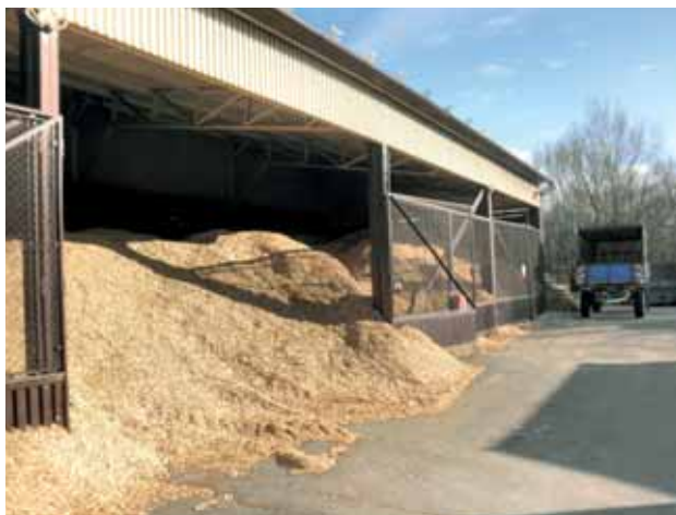
Štěpka zajišťující tepelnou soběstačnost VHP Skotnice
