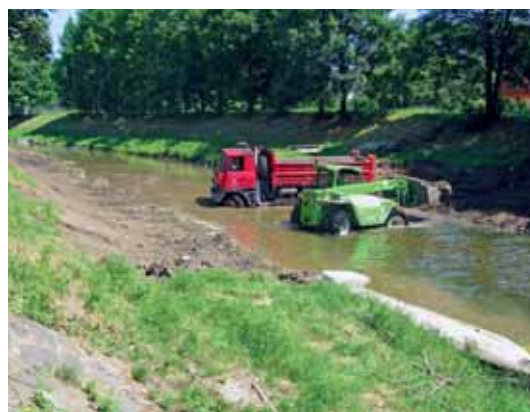
Využití těžké techniky ve VHP Skotnice
