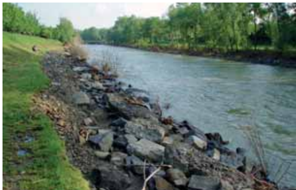
Ostravice km 22,1 Sviadnov – porost po povodni 2010
