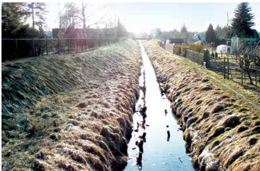
Pohled proti proudu ř. km 0,369 před rekonstrukcí
