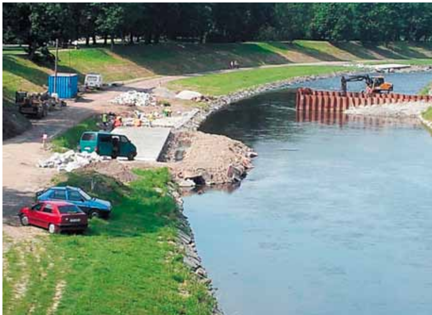
Výstavba dolního jezu a slunící plochy u Komenského sadu
