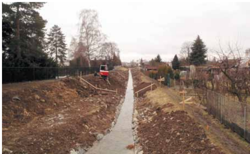
Pohled proti proudu ř. km 0,369 během rekonstrukce
