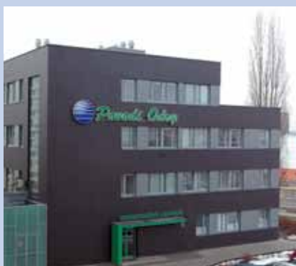
Budova laboratoří po rekonstrukci
