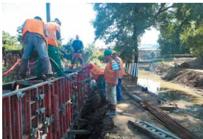
Výstavba betonových nábrežních zídek
