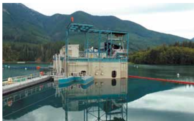
Odlovné zařízení na nádrži Baker
