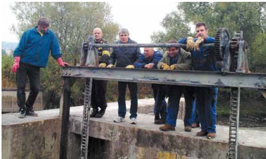
Část pracovníků při výměně stavidla na Petrově rybníku v Krnově
