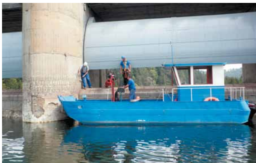
Zaměstnanci VD po zpětné montáži notové gumy
