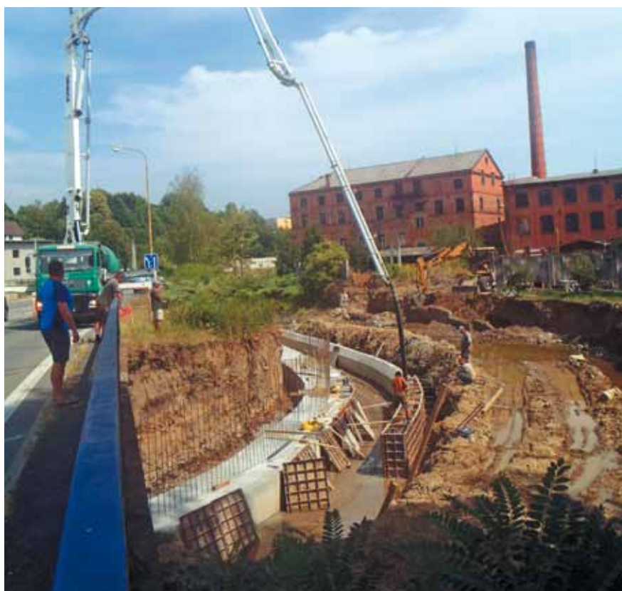
Stavba hydraulicky hladkého nátoku do mostního profilu
