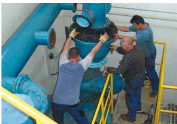
Práce na VD Žermanice
