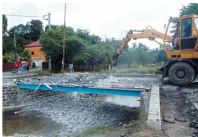
Zrušení silničního mostu
