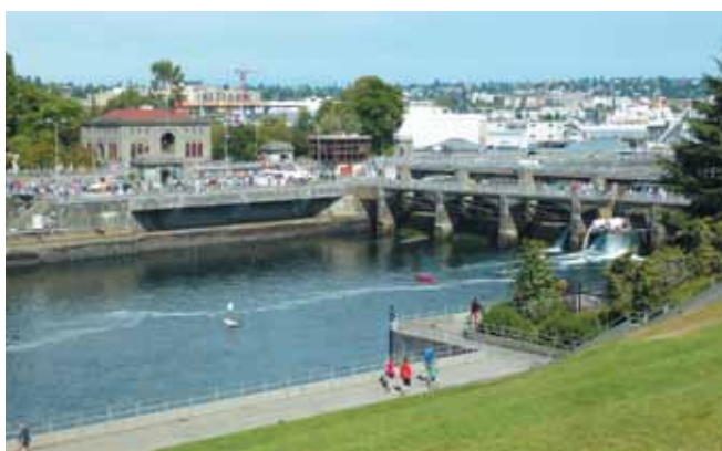
Jez, plavební komora a rybí přechod na jezeře Washington
