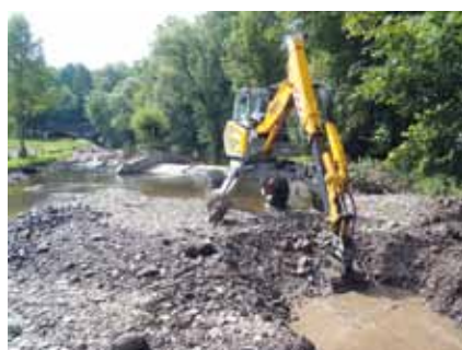
Dokončování prokopu nového koryta
