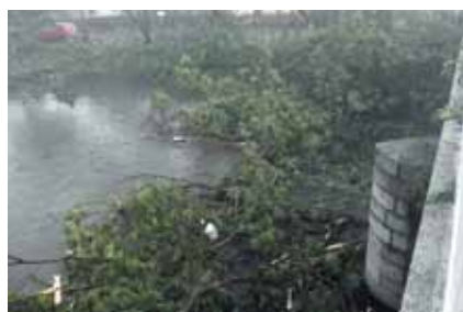
Zátaras pod silničním mostem
