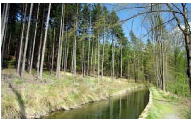
Od „papírenského splavu“ vede dosud funkční 3,7 km dlouhý náhon, který je technickou památkou. Malá vodní elektrárna v areálu býv. papíren je dosud energeticky využívána.
