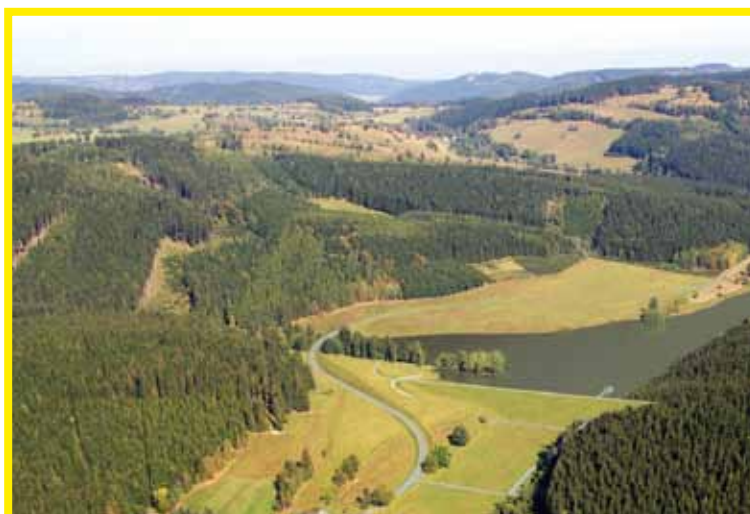
Nádrž Jelení – vizualizace nádrže ve funkci (plná nádrž za situace odpovídající 100leté povodni)
