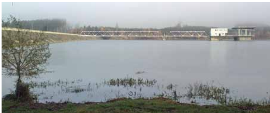
VD Želivka – těleso hráze a odběrný objekt se šachtovým přelivem
