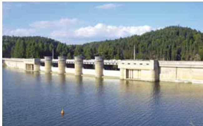
Přelivná pole v hrázi nádrže Kružberk jsou hrazena pohyblivými segmentovými uzávěry
