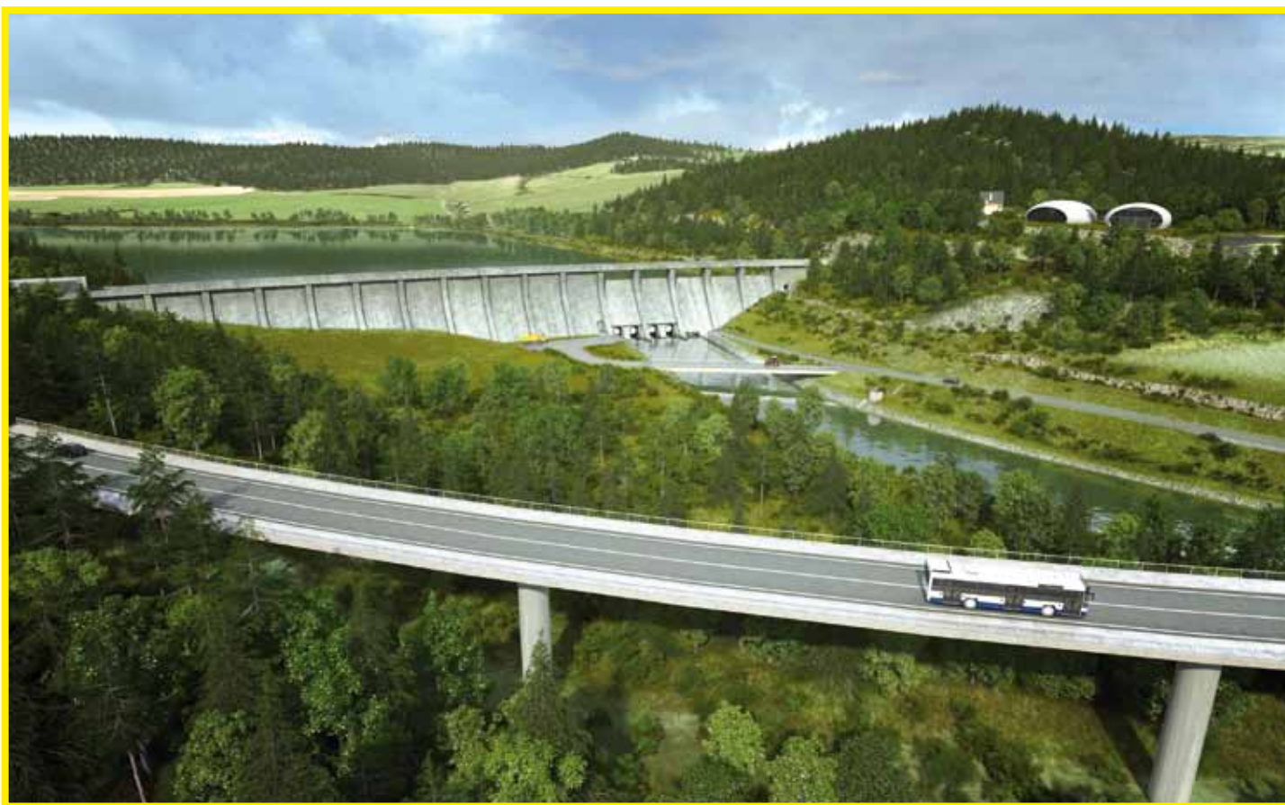
Hráz vodního díla Nové Heřminovy (betonová přehradní hráz, provozní středisko, estakáda na přeložce silnice I/45)
