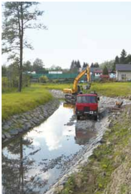
Porubka - provádění sjezdu
