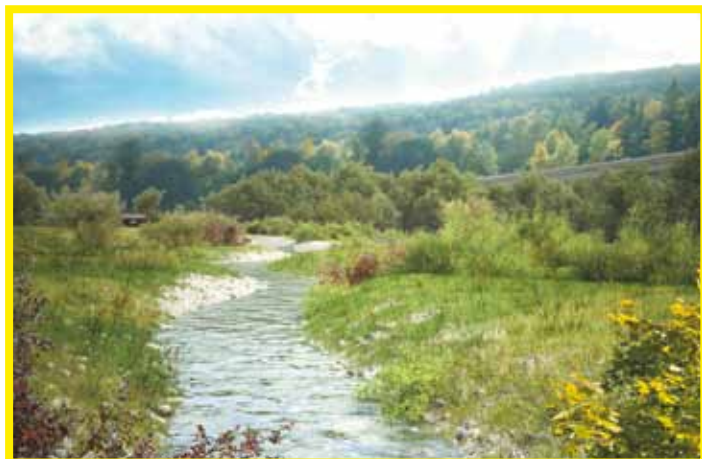
Obr. 9: Obtok nádrže v úseku obce Nové Heřminovy
