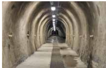
Šance - drenážní štola
