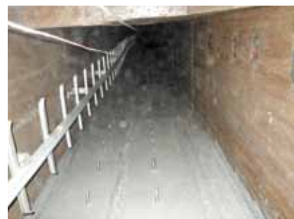
VD Žermanice – pohled do svislé šachty před instalací pryžového těsnění
