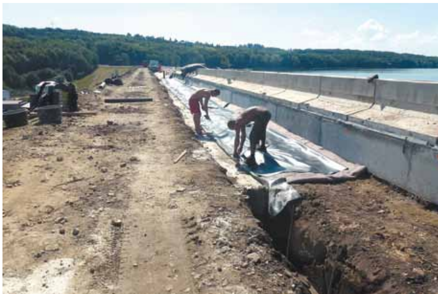
Těrlicko – pokládka hydroizolační fólie
