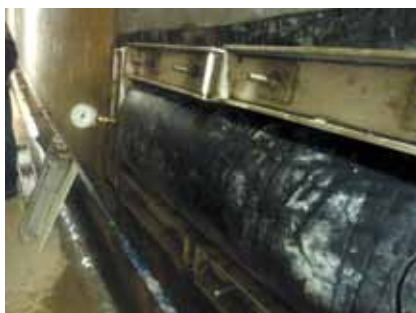
VD Žermanice – zkouška těsnění při tlaku 0,3 MPa – 30 m vodního sloupce
