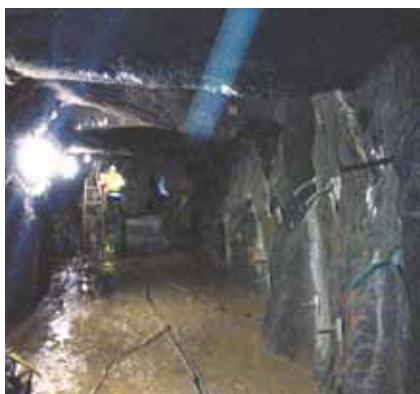
Drenážní štola na VD Morávka
