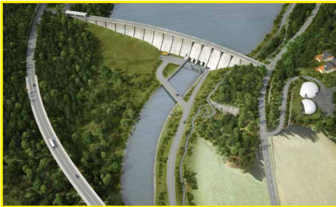
Obr. 1: Vodní dílo Nové Heřminovy, letecký pohled na prostor hráze po realizaci záměru
