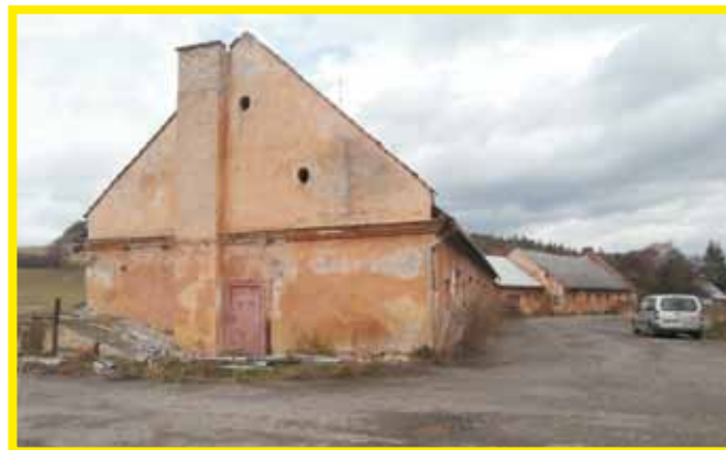
Objekt bývalého nevyužívaného vepřína v Nových Heřminovech
