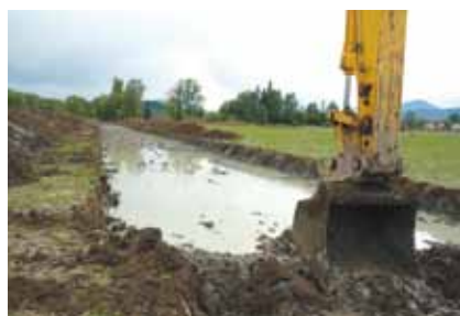
Baška – provádění odtokového koryta
