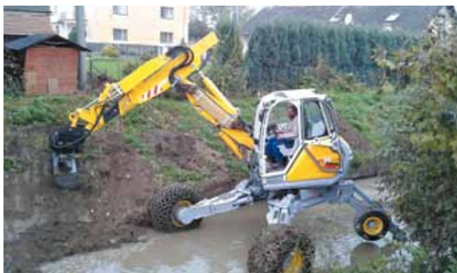
Úprava koryta potoku Sezina
