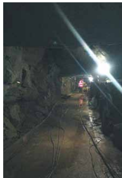
Drenážní štola na VD Morávka
