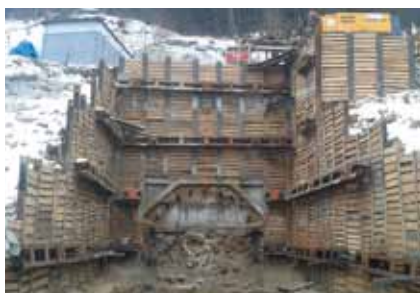
Šance – hřebíkování svahu nad stavební jámou
