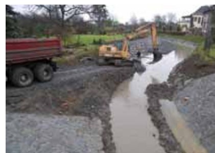
Porubka – dlažba s napojením na rovnaninu
