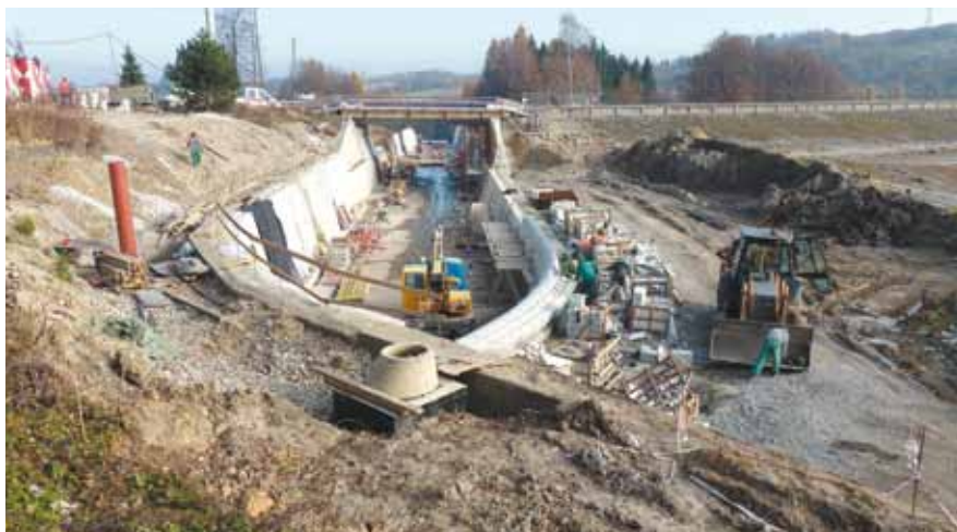
Těrlicko – oprava přelivu
