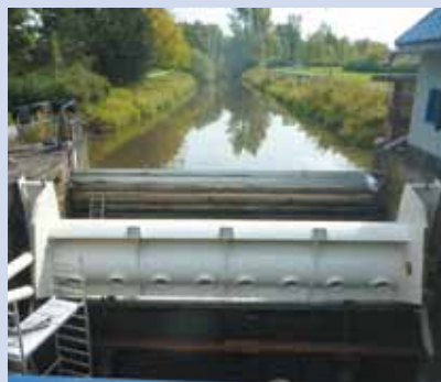
Jez Biocel – montáž nové segmentové hradicí konstrukce
