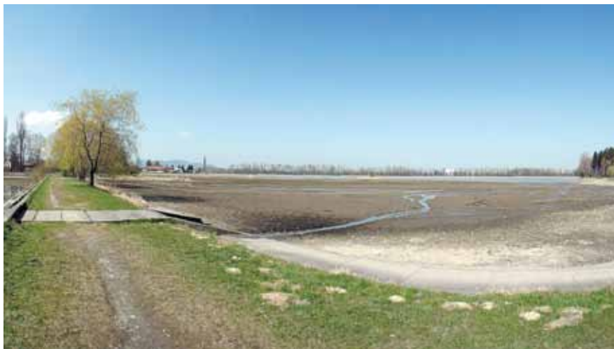
Baška – celkový pohled na plochu odtěžení nánosů před zahájením akce
