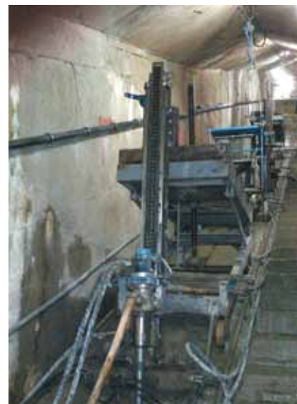
Šance - dotěsnění LB a zavázání - injektáž vrtu č. 313C
