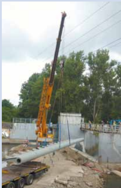
Jez Vítkovice – montáž nových hradicích těles klapkových uzávěrů
