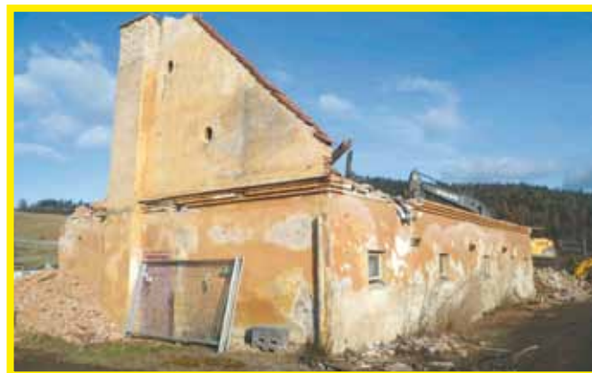
Demolice vepřína v Nových Heřminovech
