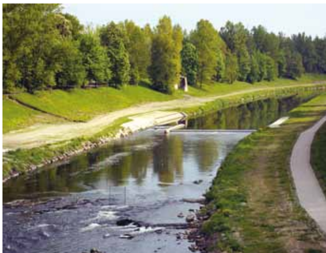
Vzdouvací objekt v podobě Jamborova prahu pro lepší možnost vodáckého využití řeky
