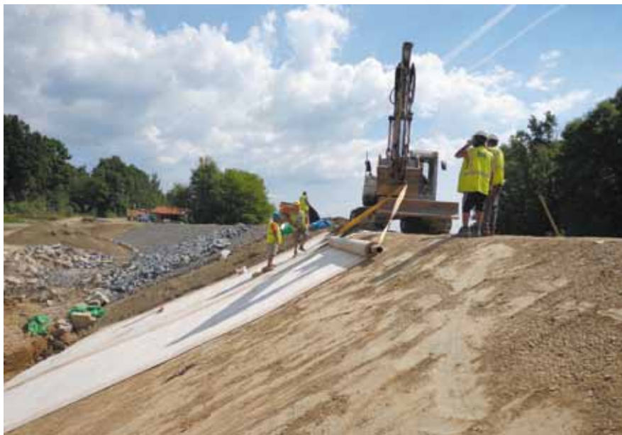
Pokládka bentonitové rohože
