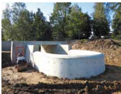
Přelivná hrana bezpečnostního přelivu
