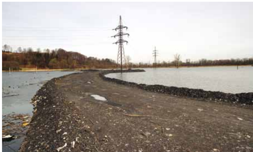
Postupující vlivy důlní těžby se na Olši v současné době nejmarkantněji projevují v lokalitě levobřežní laguny Kozinec (na úrovni km 18,5 - vlevo souběžná laguna Karvinského potoka)
