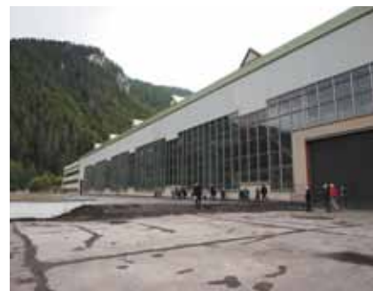
Venkovní pohled na strojovnu PVE Čierny Váh
