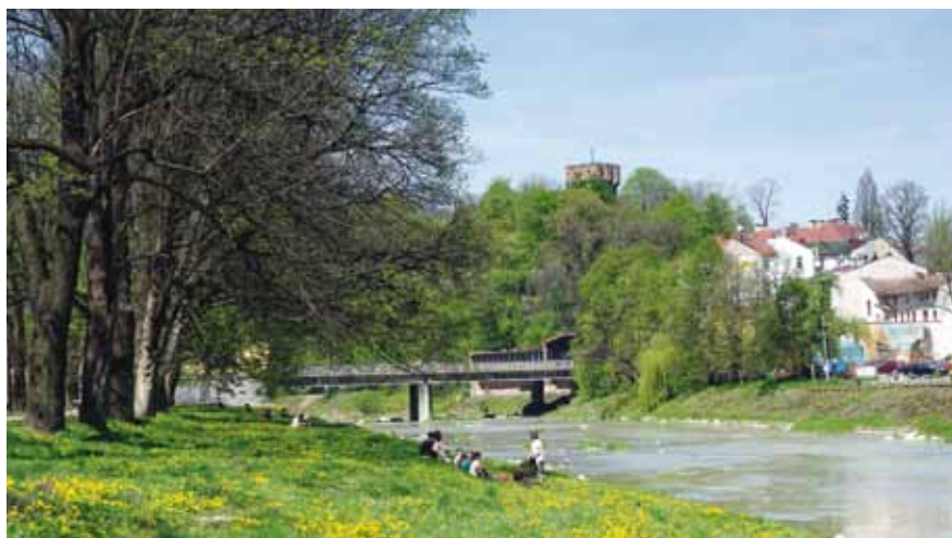
Regulovaný úsek řeky Olše (km 37,4 – po toku) přes dvojměstí Český Těšín (ČR) – Cieszyn (PR)
