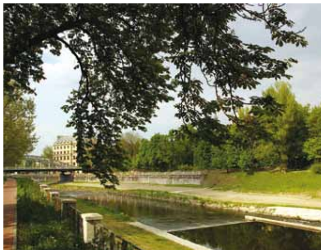
Dnešní podoba nábřeží Ostravice s opěrnými zdmi a se souběžnou cyklistickou stezkou nad Sýkorovým mostem
