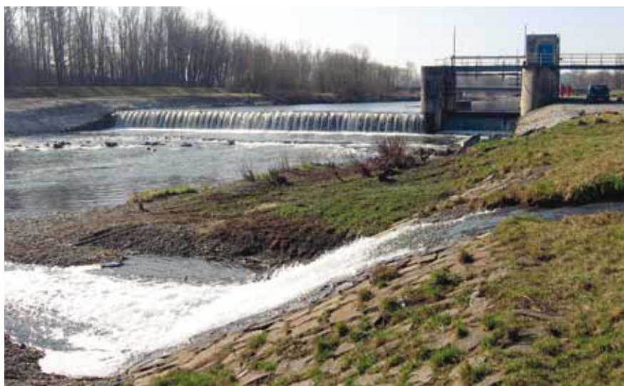
Na úseku od Petrůvky po Karvinou-Ráj (km 12,8–25,6) patří k nejvýznamnějším říčním objektům jez (km 15,8), který zásobuje Elektrárnu Dětmárovice provozní vodou. Pod odběrné místo je zaústěn Karvinský potok, odvádějící slané důlní vody z východní části revíru
