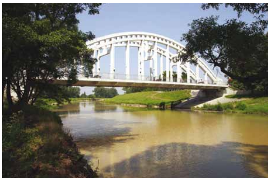
Most Sokolovských hrdinů (km 23,8) je technická památka (Vierendeelův nosník), jejíž konstrukce byla zvýšena o 1,5 metru, když most vlivem poddolování zaklesl pod úroveň návrhového povodňového průtoku. Most je dnes součástí promenádní trasy lázní Darkov
