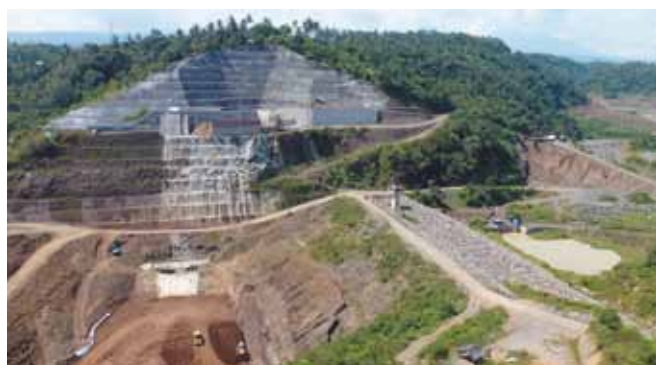
Staveniště přehrady Titab
