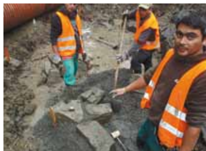
Sedlnice – začátek kladení dlažby do betonu, km 3,123
