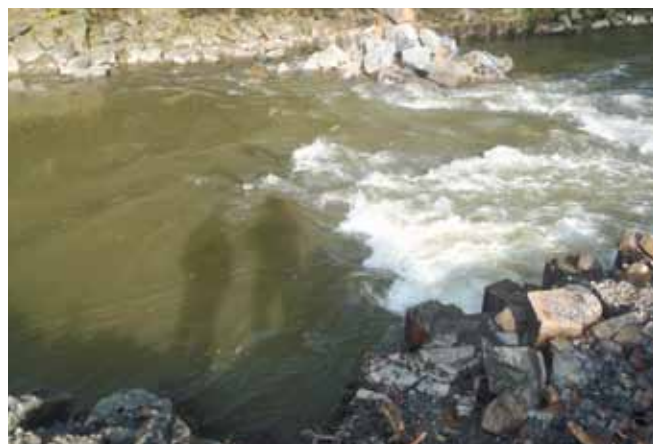
Zprůchodnění na Odře, Polanka – skluz 23,1
