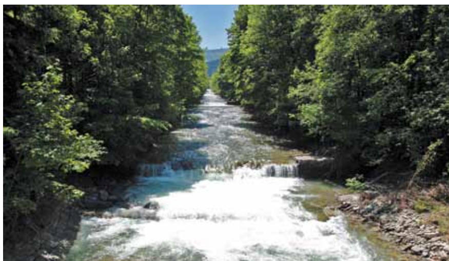
Upravený 2,4 km dlouhý dolní úsek Mohelnice za zvýšeného průtoku před chystanou rekonstrukcí koryta
