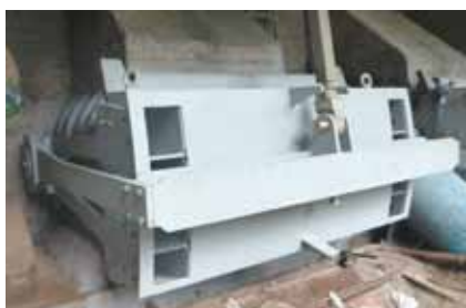
VD Těrlicko – regulační segmentový uzávěr po opravě
