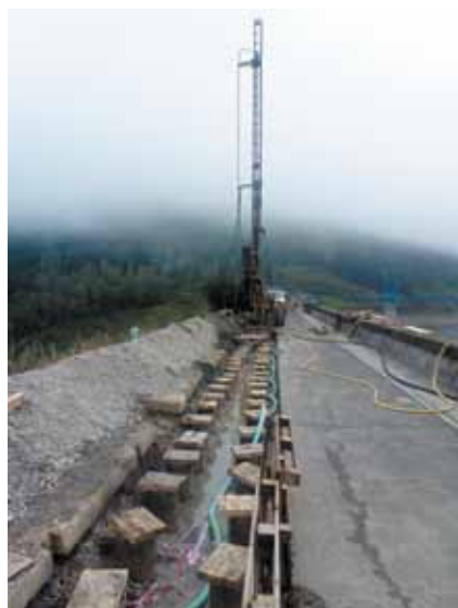
Probíhající oprava těsnicího jádra VD Šance
