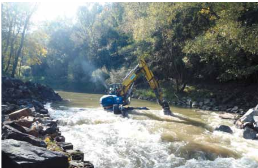
Zprůchodnění na Odře, Polanka – km 23,1
