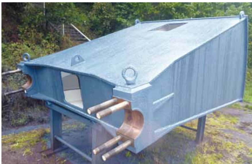
VD Kružberk – regulační segmentový uzávěr po aplikaci speciálního nátěru
