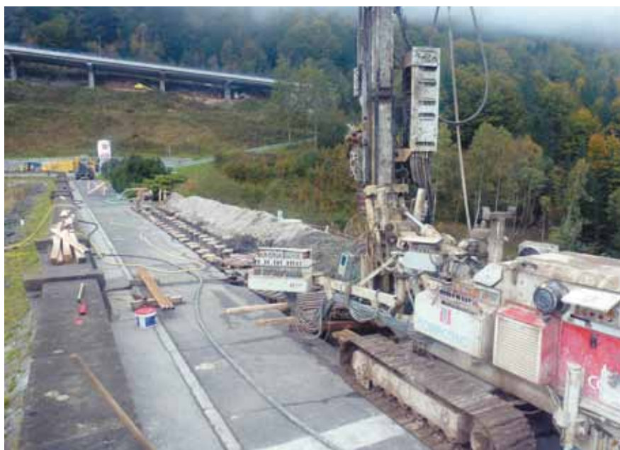
Probíhající oprava těsnicího jádra VD Šance
