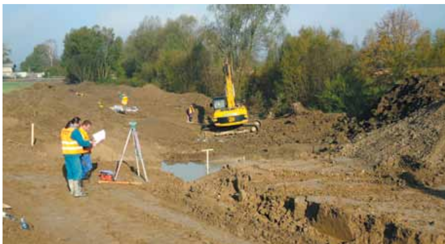
Sedlnice – pohled po proudu
