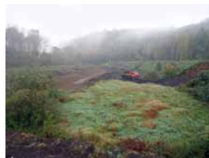
Probíhající revitalizace odstaveného ramene Odry v Přívoze
