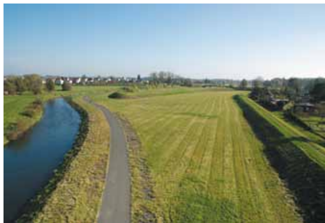
Uvolněný prostor pravobřežní inundace na dolním konci městského úseku nad křížením řeky Opavy s tratí ČD Opava – Hlučín
