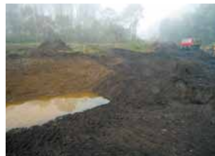
Probíhající revitalizace odstaveného ramene Odry v Přívoze
