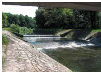
Lubina – stabilizační stupeň v místě křížení se silnicí I/58 (Ostrava – Mošnov – Příbor)
