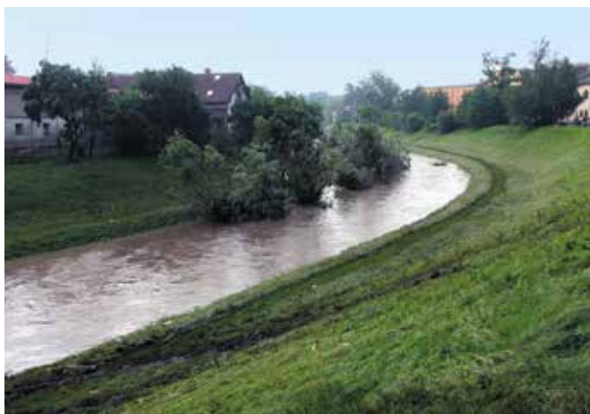
Jičínka – upravené koryto přes Nový Jičín po povodni v roce 2009
