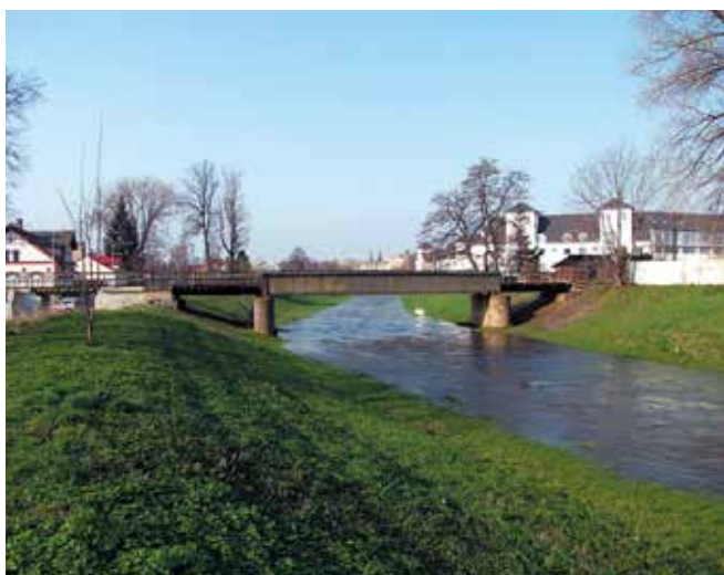
Železniční most přes řeku Opavu ve spodním úseku její úpravy
