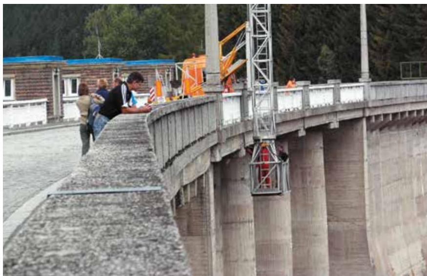
Průzkum koruny hráze (srpen 2007)
