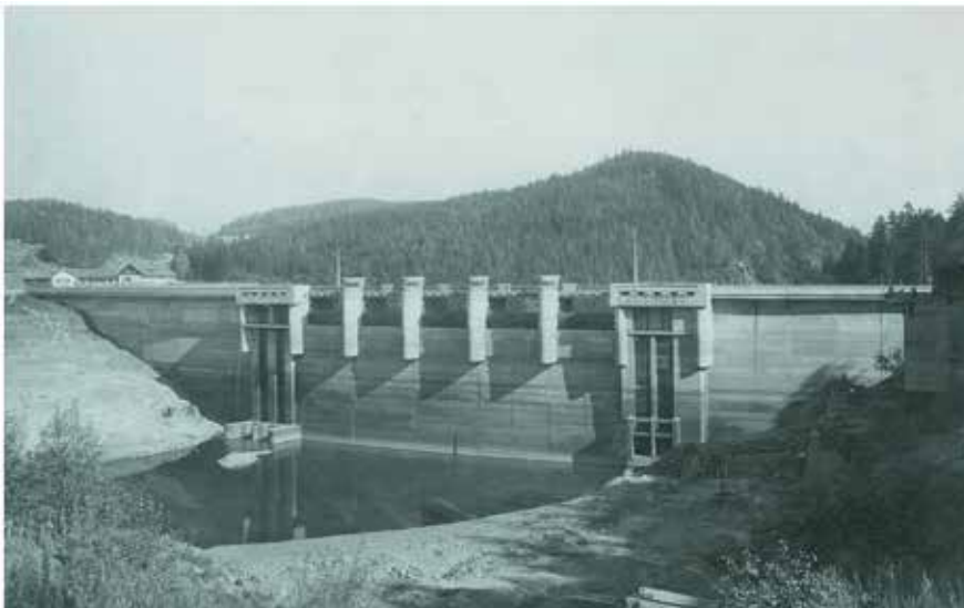
Hráz před napuštěním
