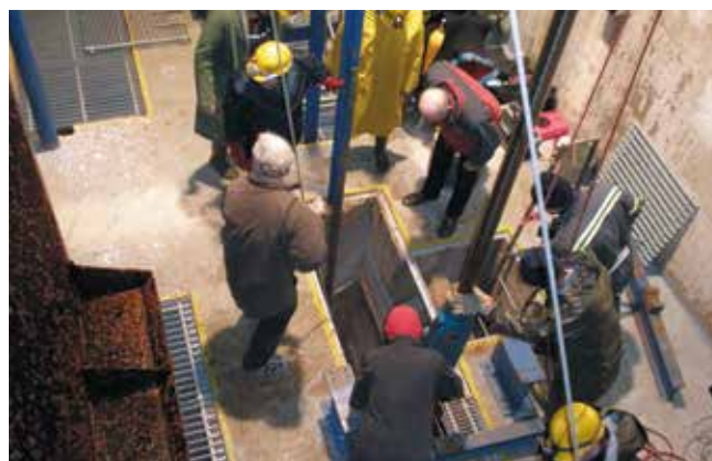
Revize tlakové štolý 2010 – příprava před vstupem do štolý
