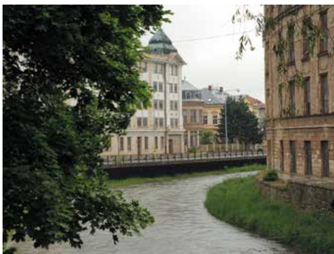
Stísněné poměry si vynutily vyložení silnice na konzoly nad průtočný profil řeky
