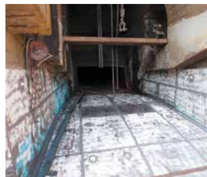
Komora pravé spodní výpusti po demontáži segmentového uzávěru (říjen 2014)
