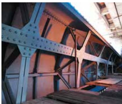
Oprava segmentů přelivů (červenec 2013)
