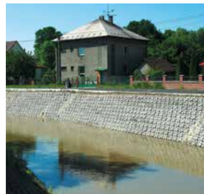
Ondřejnice – stísněné poměry ve Staré Vsi nad Ondřejnicí si při zkapacitnění koryta (2010) vyžádaly tento „tvrdý“ způsob úpravy
