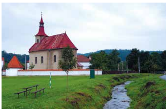
Luha – úprava horní trati přes obec Nejdek
