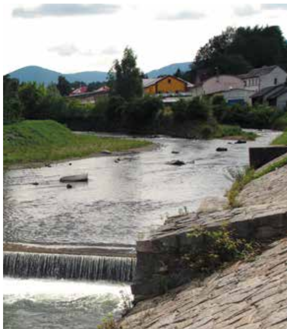
Rekonstruovaný stupeň s rybím přechodem na Bělé pod soutokem se Staříčem
