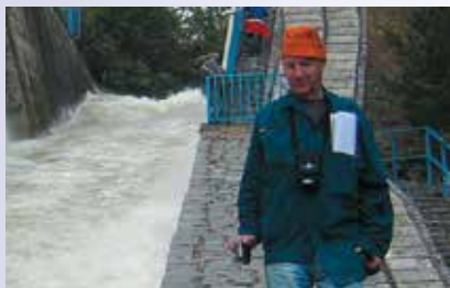
Zkouška převádění zvýšených průtoků skluzem VD Dalešice (2009)
