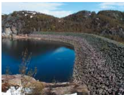
Rockfillová hráz – jedna z mnoha na nádrži Kilen
