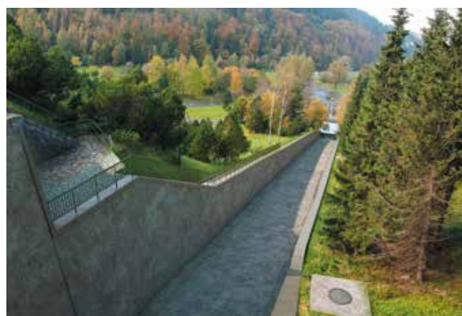
Navržený stav – zvýšení LB zdi skluzu
