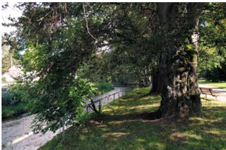
Pravobřežní opěrná zeď podél parku pod Smetanovými sady
