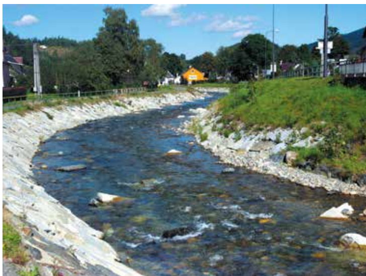
Opevnění břehů těžkým kamenným záhozem v Jeseníku-Bukovicích
