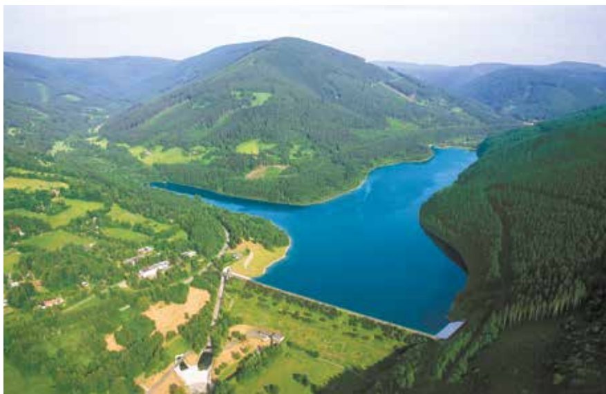
Letecký pohled na přehradu Morávka
