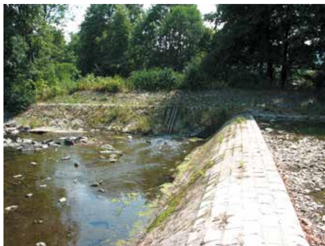
Jez na Odře v Jakubčovicích nad Odrou při průtoku 0,08 m 3 /s
