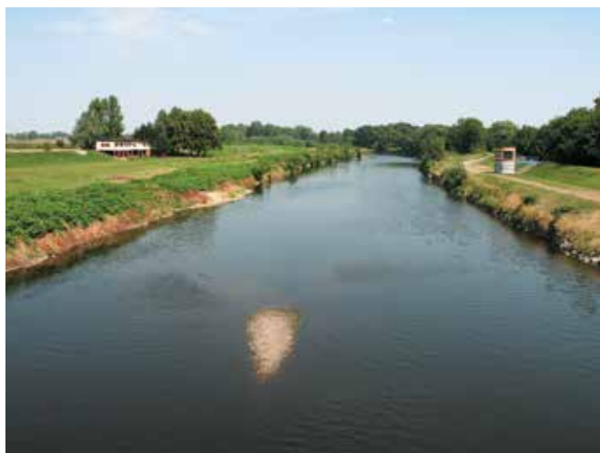
Koryto Odry v Bohumině při průtoku 7,7 m 3 /s
