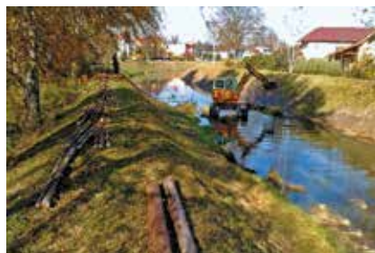
Luha – sedimentace nánosů transportovaných z výše ležícího povodí vyžaduje časté odtěžování
