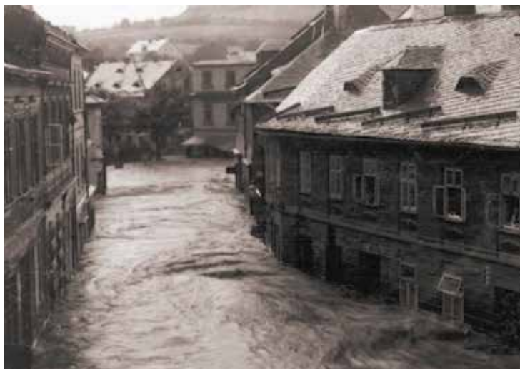
Lipovská ulice v Jeseníku za povodně v roce 1903
