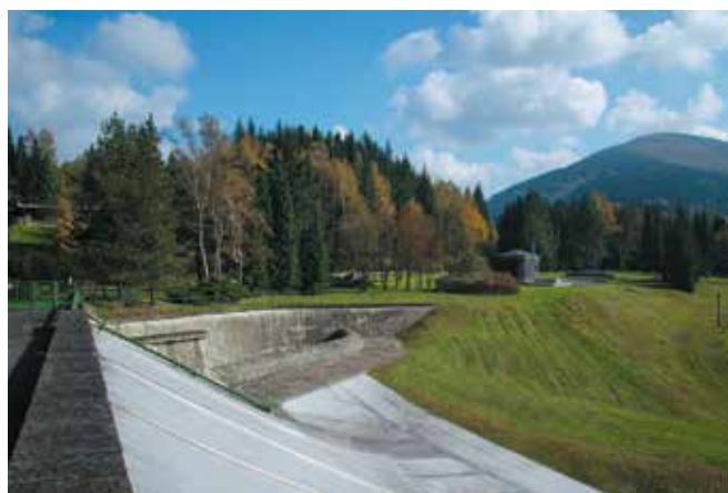
Původní stav objektu přelivu
