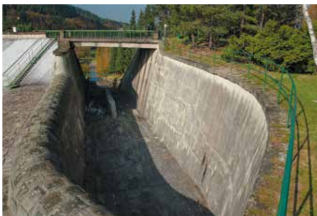
Původní stav objektu přelivu
