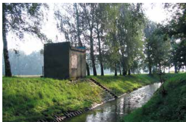
Bílovka – při opevnění břehů se v upravených úsecích v dolní trati často používaly tzv. polovegetační tvárnice
