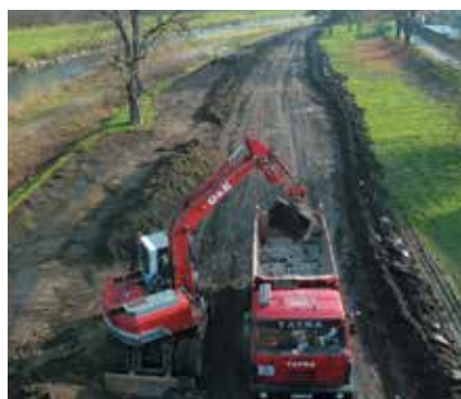
Odtěžení sedimentů z bermy nad Koloredovským mostem
