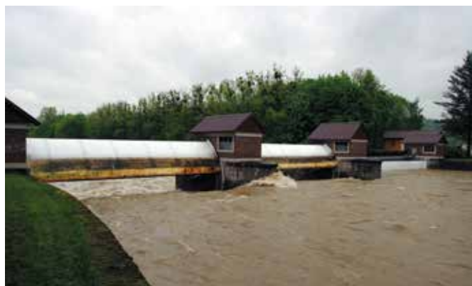
Morávka - rozdělovací objekt ve Vyšních Lhotách slouží pro převod vody z řeky Morávky do povodí Lučiny (stav za povodně v roce 2010)
