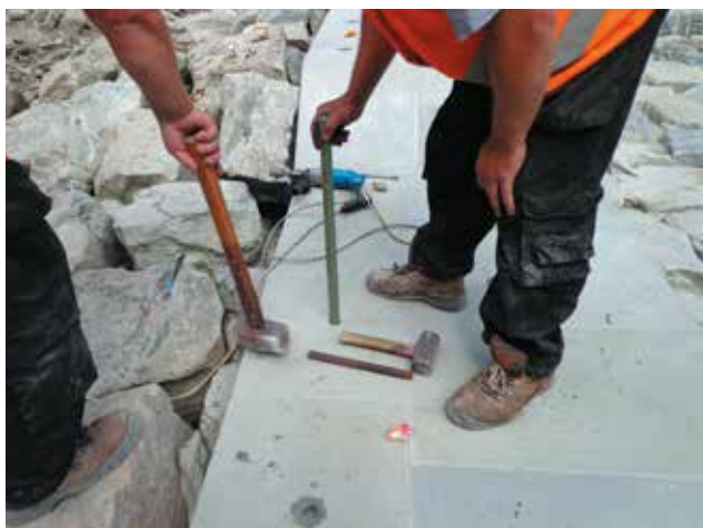
Kotvení kamenného obkladu sklolaminátovou tyčí
