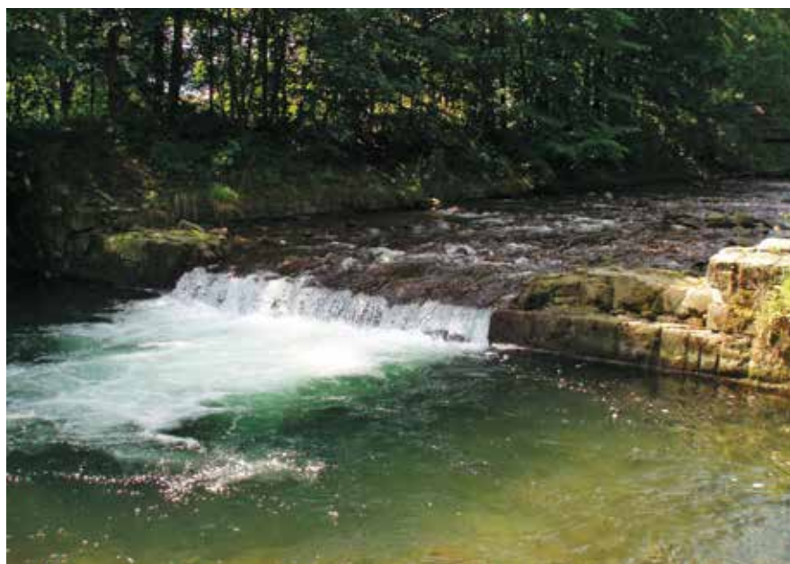
Spádový stupeň 01 – původní stav
