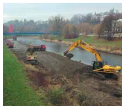
Odtěžení štěrkové lavice pod mostem Hlavní třída
