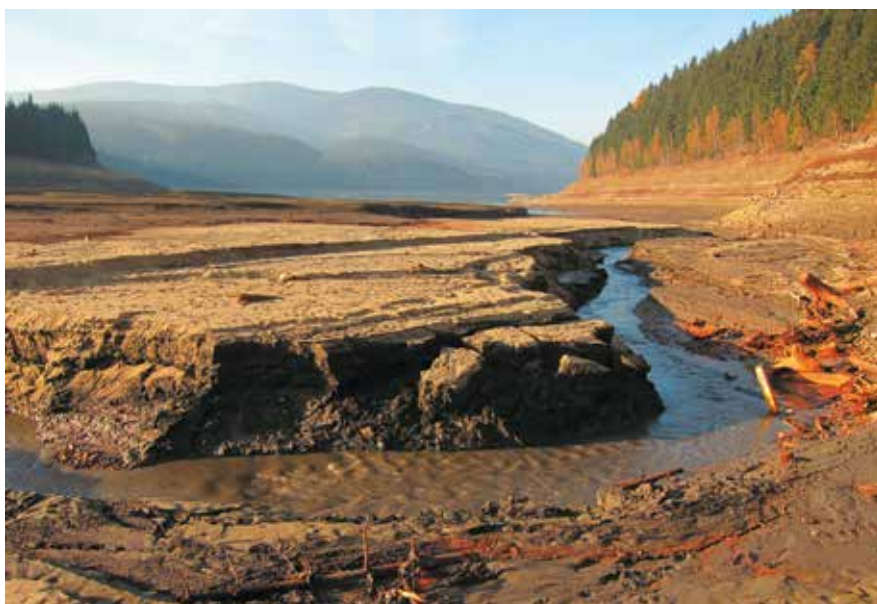
Fotodokumentace sucha ze 4. listopadu 2015 v povodí Odry s jeho dopadem na údolní nádrž Šance a její zdrž (zásobní objem 8,7 milionu m 3 , naplnění z 22 % a zákles 20 m). Bez přijatých opatření by zásoba vody pokrývala časové období pouze do začátku dubna 2016.
