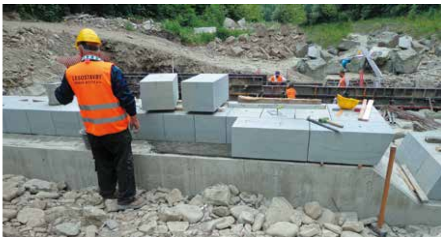
Obklad přelivné hrany kamennými kopáky z godulského pískovce
