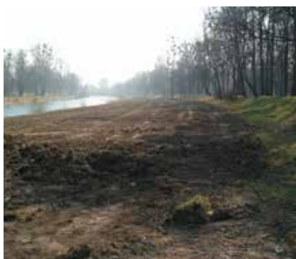
Terénní úpravy na bermách
