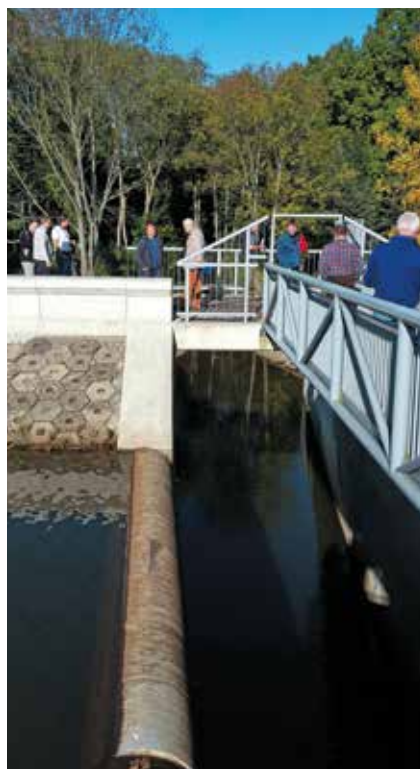
VD Dráteník – nový přeliv procházející hrází
