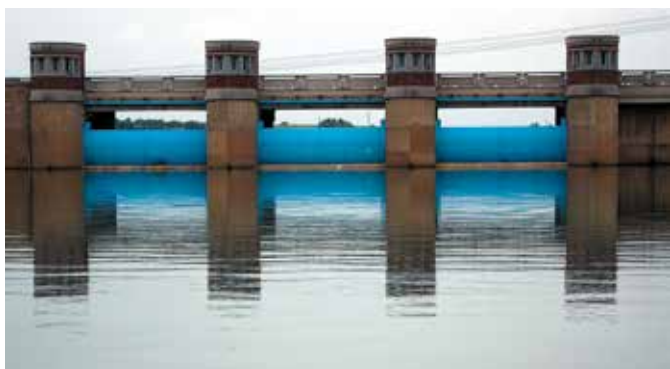
Přehrada Žermanice má tři pole bezpečnostního přelivu hrazena tzv. segmentovými uzávěry
