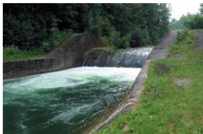
Přivaděč Morávka - Žermanice, na jehož téměř 10 km je vybudováno 21 spádových stupňů
