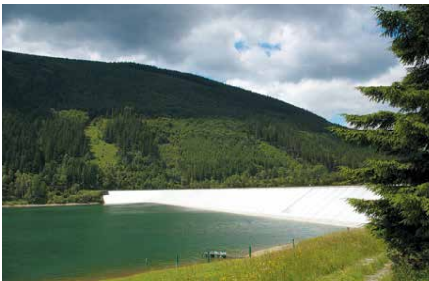
Morávka – hráz stejnojmenné údolní nádrže po rekonstrukci v letech 1997 až 2000; je těsněna geomembránou Sibelon
