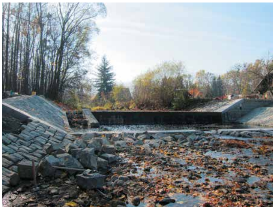
Spádový stupeň 02 (nad mostem v Raškovcích) před dokončením
