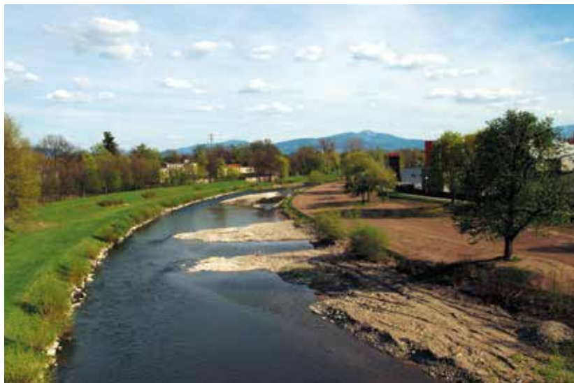
Levobřežní předhrází průtočného profilu po odtěžení nánosů v roce 2015
