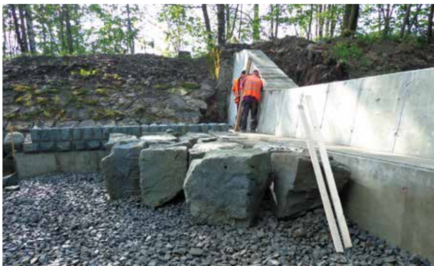
Provádění kamenného opevnění vývaru stupně
