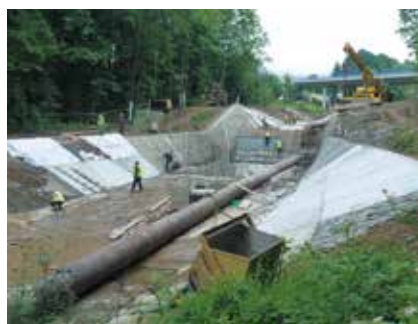
Stupeň č. 11 – betonáž přelivné hrany
