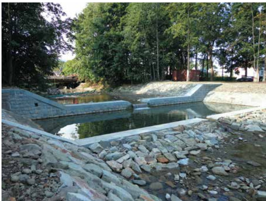
Spádový stupeň 01 (pod mostem v Raškovících) po obnově
