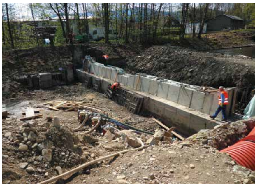
Vybetonované jádro přelivné hrany
