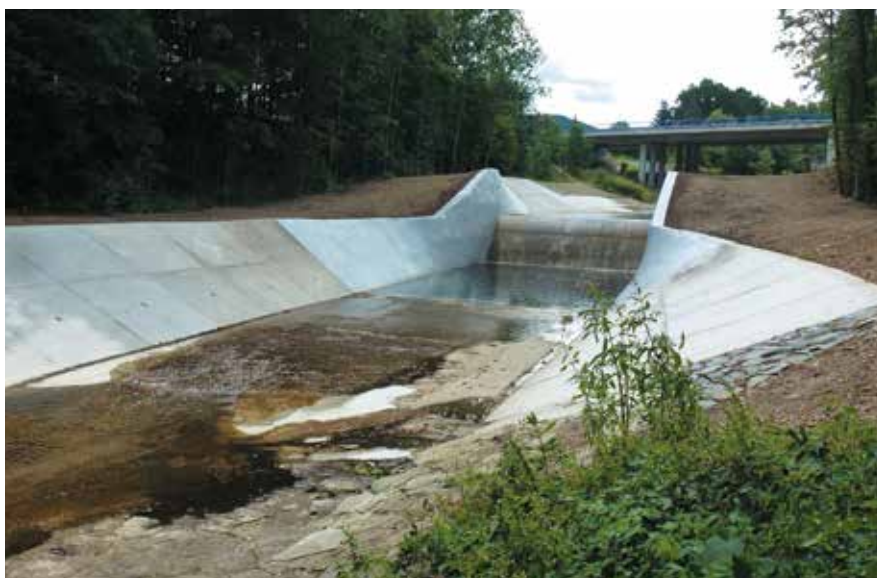
Stupeň č. 11 dokončené dílo – pohled proti vodě
