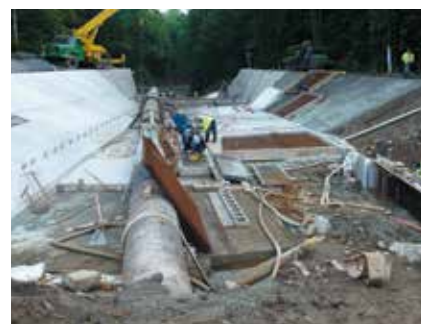
Stupeň č. 11 – úprava nad stupněm
