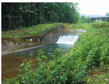
Stupeň č. 11 před opravou
