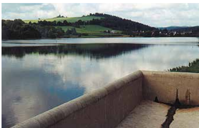
Dnešní podoba bezpečnostního přelivu a části záplavy nádrže Pocheň na Čižině
