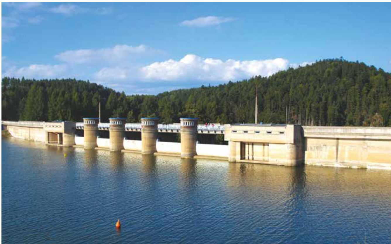
Betonová tížní hráz nejstarší údolní nádrže v povodí (Kružberk, 1955)
