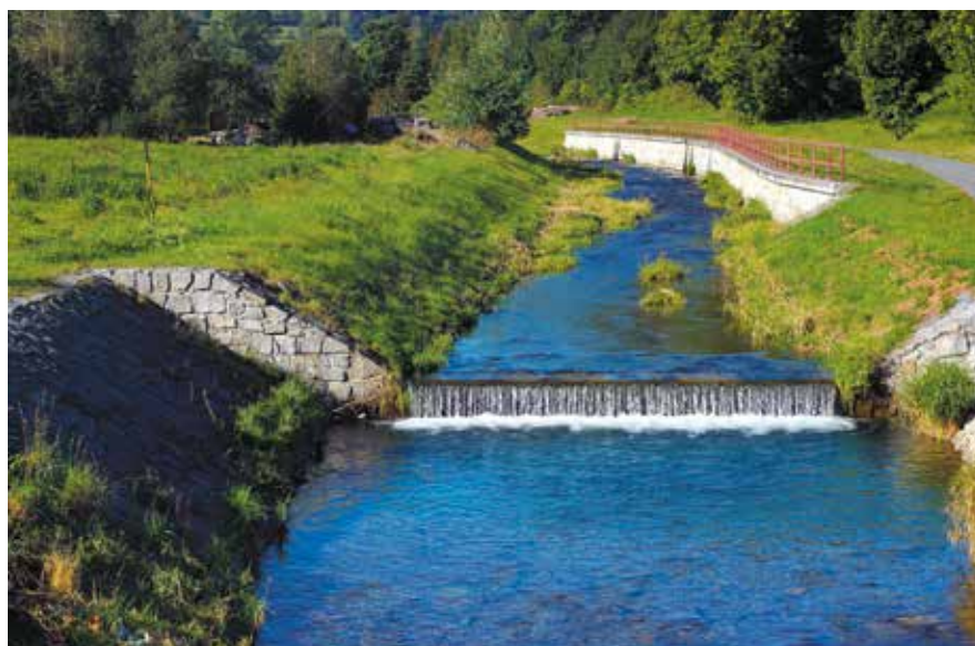
Opavice přes intravilány obcí Hynčice – Hejnov – Holčovice po provedené úplné obnově koryta po povodni v roce 1997
