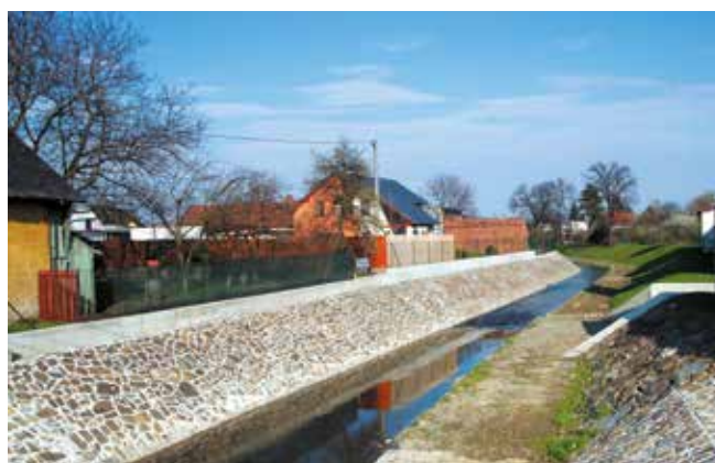
Hvozdnice, na níž si časté záplavy obce Otice v poslední době vynutily zkapacitnění koryta na 20letou vodu
