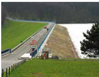
Koruna sypané hráze údolní nádrže Těrlicko (rekonstruovaná v roce 2014)
