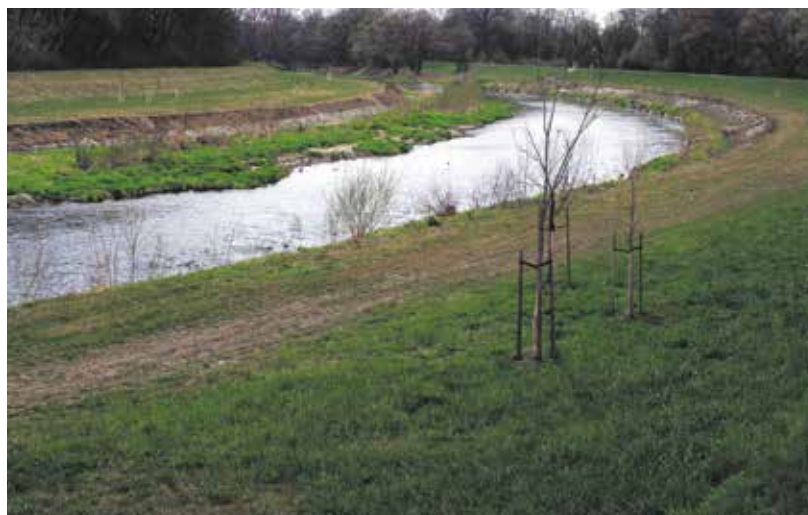
Současná podoba průtočného profilu Olše podél Karviné po odtěžení nánosů z předhrází
