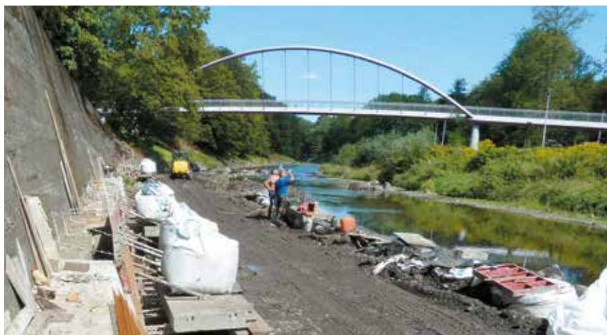
Oprava patky na Olši v Českém Těšíně
