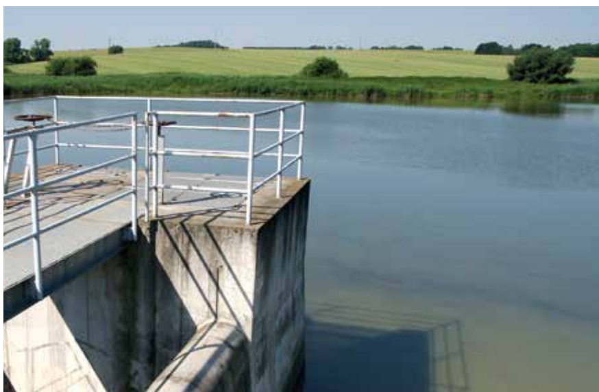
Výpustný objekt na malé vodní nádrži Hať
