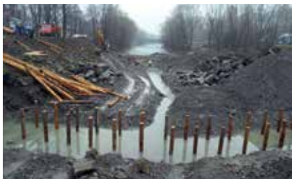
Zahájení prací na opravě balvanitého stupně na Ostravici
