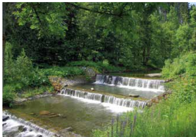
V horní části je tok stabilizován bystřinářským způsobem stále funkčními 12 kamennými stupni
