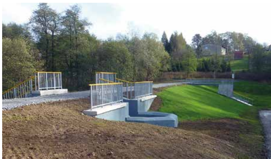
Hráz nádrže Lutyňka
