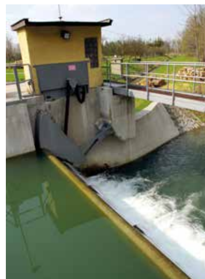
Ropičanka je opatřena rozdělovacím objektem, jímž se její vody převádějí do řeky Stonávky s nádrží Těrlicko
