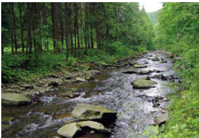
Snaha o úspory (1960–1970) vedla dřívější Severomoravské státní lesy v lesní trati k úspěšné náhradě spádových objektů pohozem dna balvany
