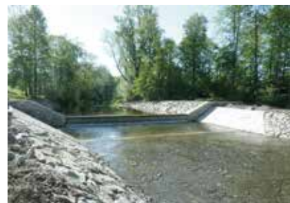
Stonávka v Třanovicích stupeň v km 22,658 po dokončení
