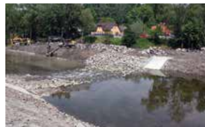
Oprava balvanitého stupně před dokončením
