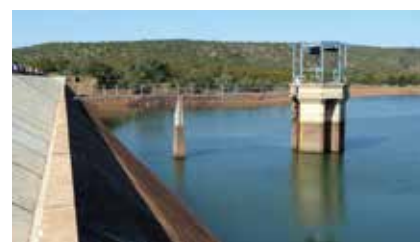
Zvyšovaná rockfilová hráz Rust de Winter
