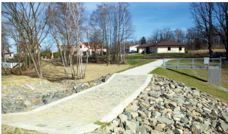
Bývalý rybník Hlinský I byl rekonstruován na malou vodní nádrž
