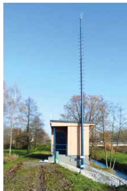
Měřicí stanice po rekonstrukci
