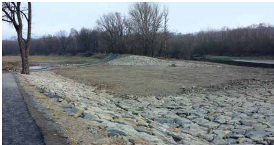
Zrušená LB hráz nad Karvinou, protipovodňovou funkci zajišťuje souběžně vedená komunikace (2014)
