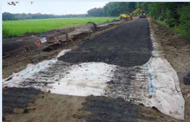
Olše - provádění zpevněné koruny hráze ze štěrkodrti
