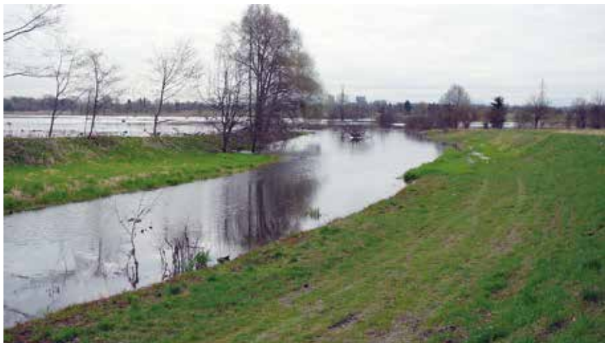
Koryto Karvinského potoka pohlčené poklesovou kotlinou (2011)
