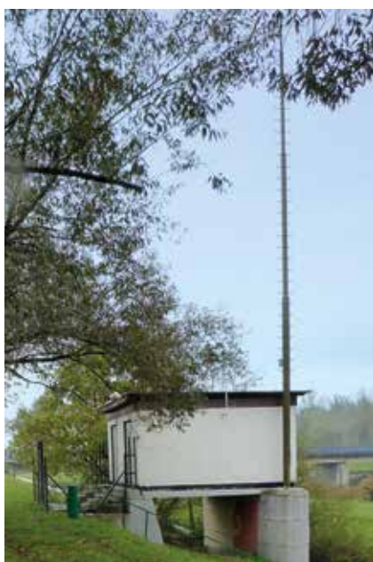
Měřicí stanice před rekonstrukcí
