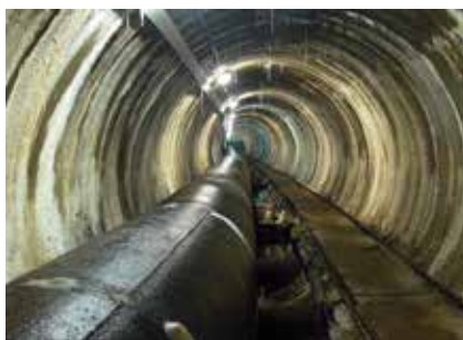
VD Souš – chodba spodní výpusti
