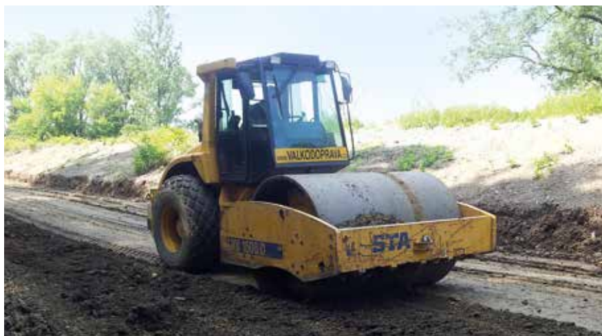
Zvyšování PB hráze Olše z důvodu poklesů terénu v Karviné (2013)
