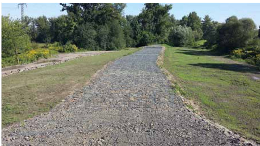
Přeliv na LB hrázi pro převádění průtoků do kotliny v Kozinci
