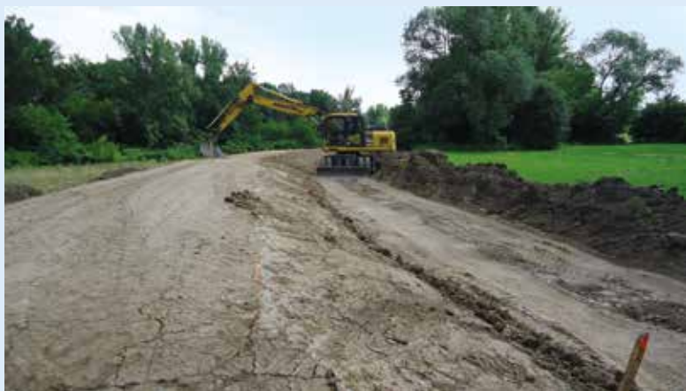
Olše - provádění zemního tělesa hráze
