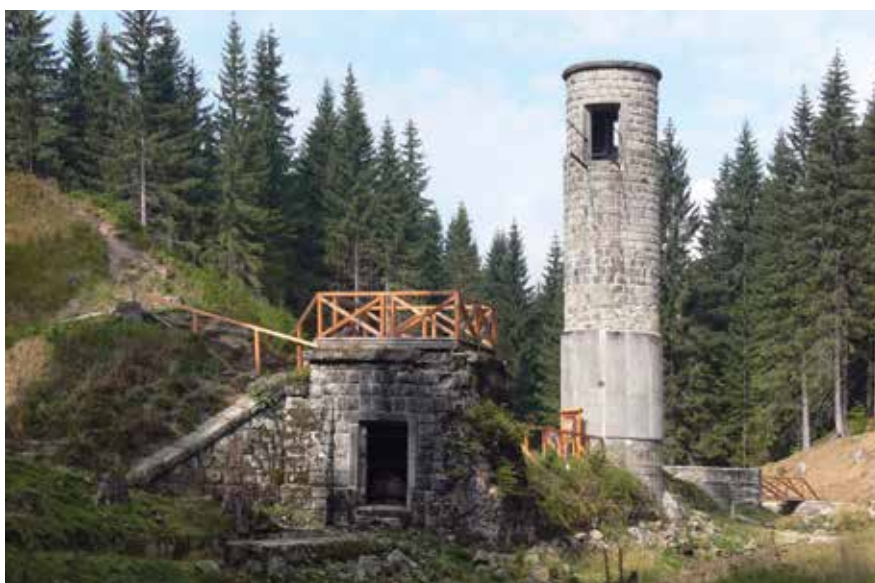
Bílá Desná – věž a šoupátková komora
