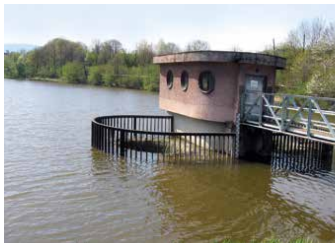
Manipulační objekt na nádrži Štramberk
