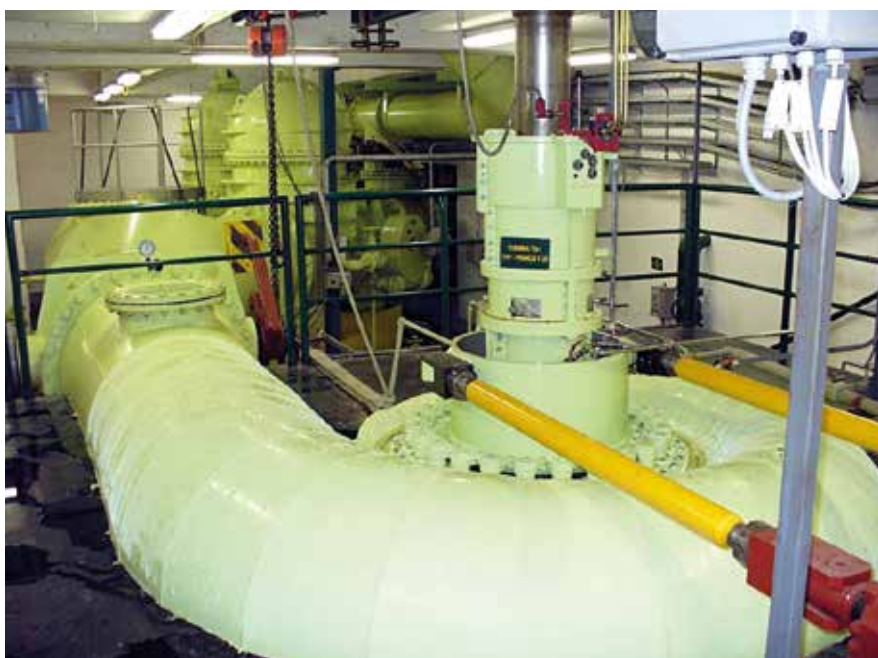
Slezská Harta - vertikální Francisova turbína
