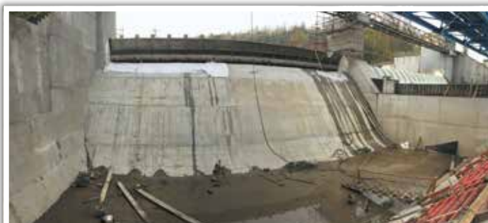
Jez Vítkovice – přelivná plocha po betonáži
