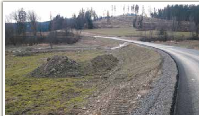
Pravobřežní přeložka silnice II/452
