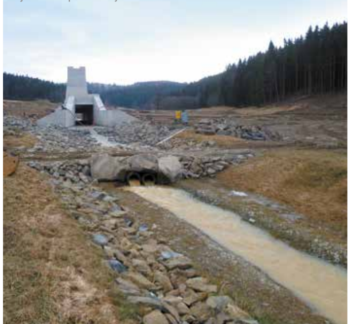
Opevnění na výstupu ze sdruženého objektu a odpadní koryto
