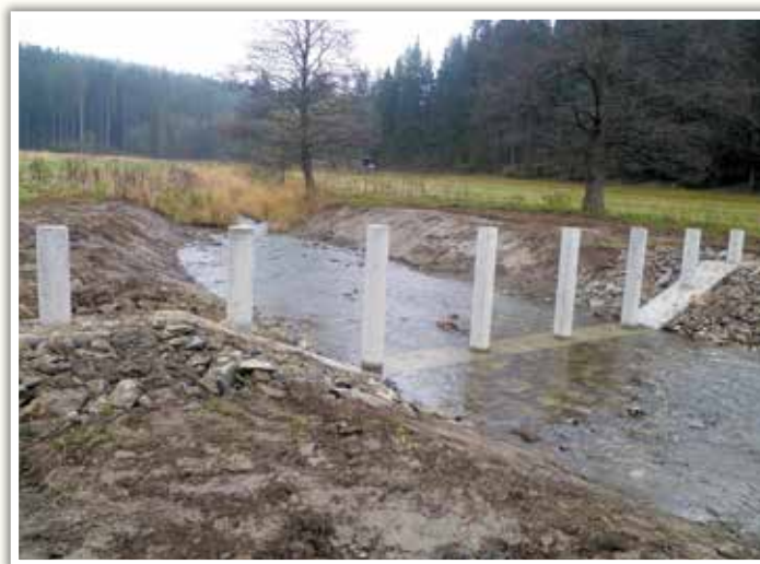
Záchytný systém nad nádrží
