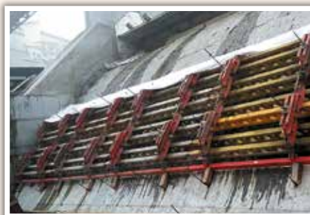
Realizace přelivu (podzim 2018)
