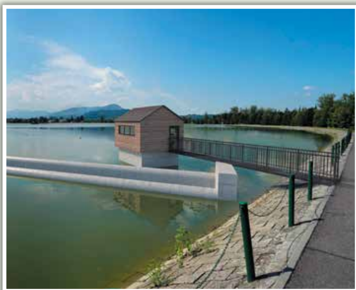
Rekonstrukce přelivu na vodním díle Baška
