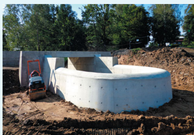
Spillway safety edge
