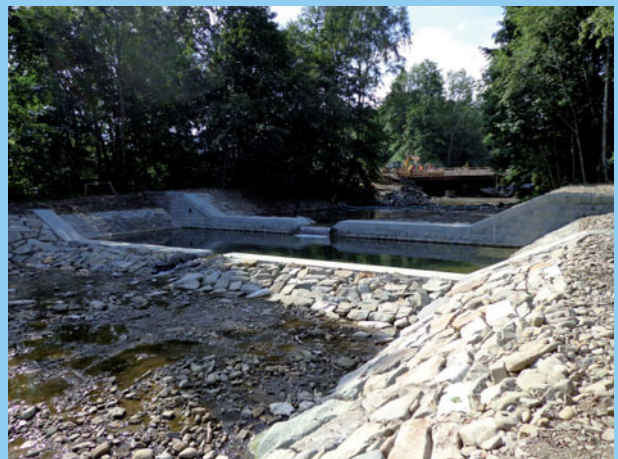
Mohelnice – Objekt 1 celkový pohled po dokončení
