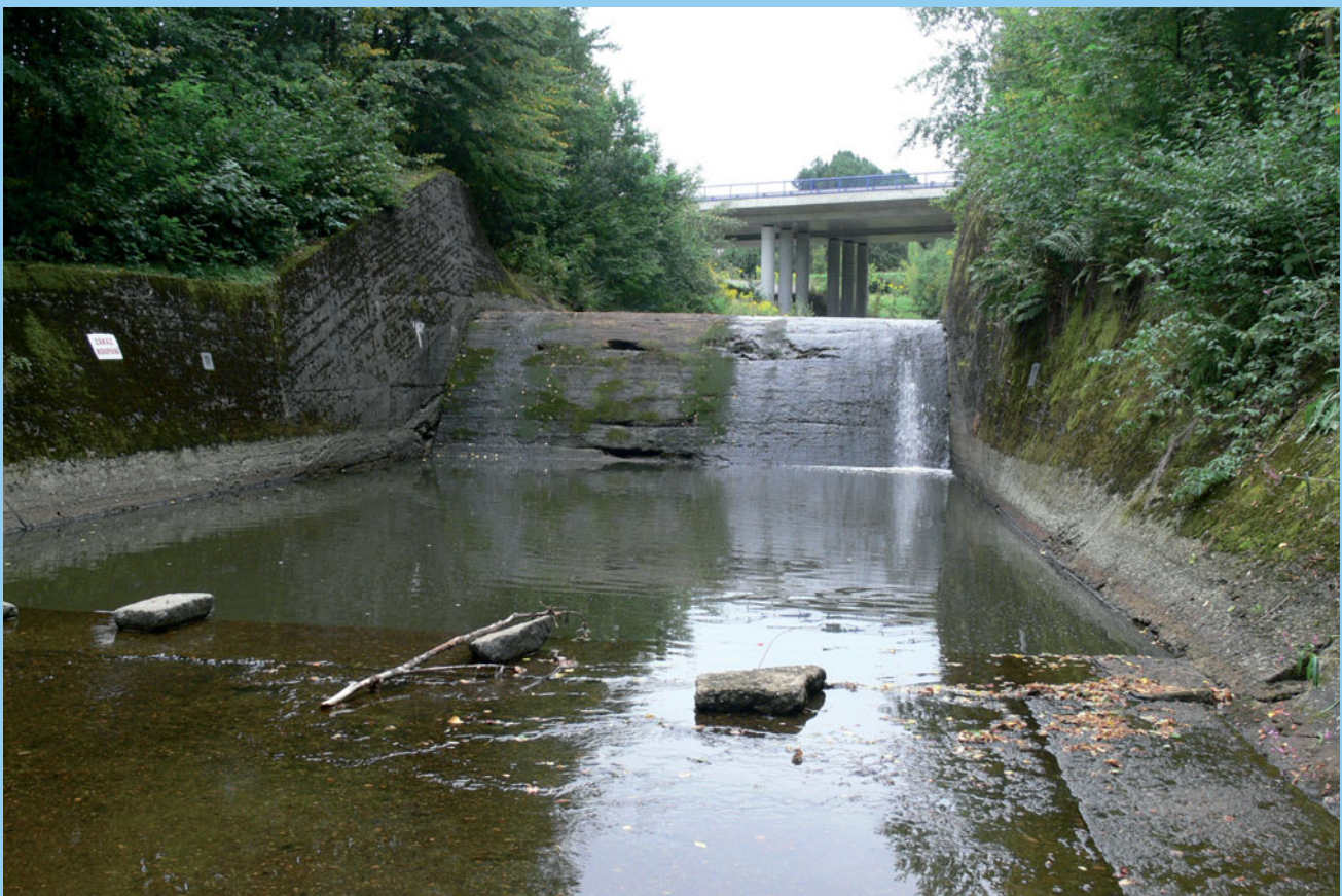
Stupeň 11 před opravou
