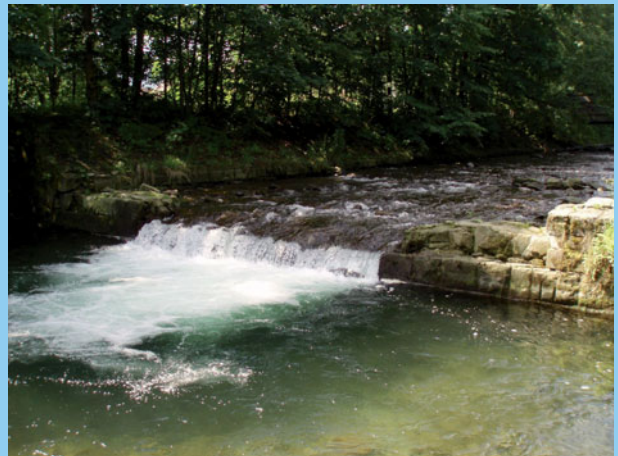
Mohelnice – Objekt 1 původní stav
